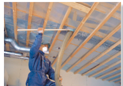
Selluvilla SV:n asennusta ontelopuhallustekniikalla. Selluvilla mahdollistaa höyrynsuluttoman - tai sulullisen rakenteen.
