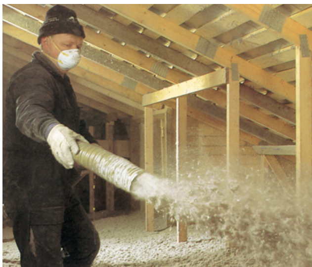
Selluvilla SV : n asentamista vapaaseen yläpohjaan.
